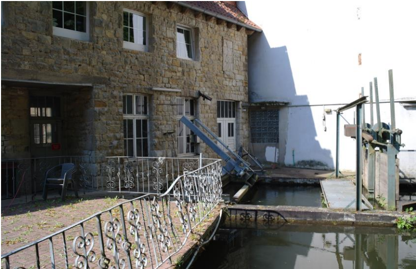
Wasserkraftwerk mit Staustufe-2016
