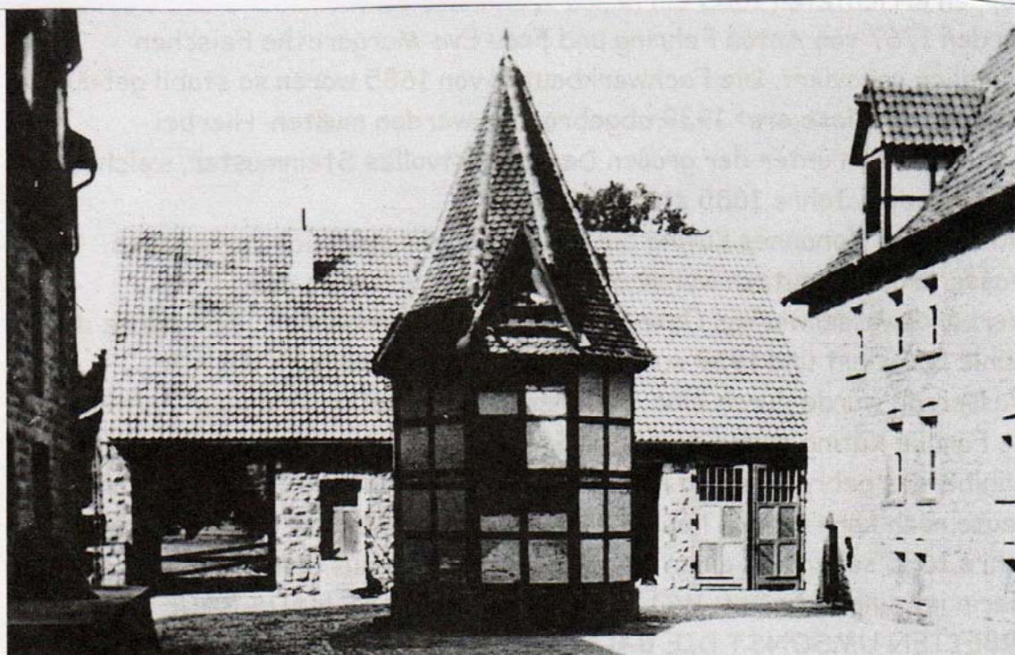
Das Geflügelhaus der Klifmühle bekannt als „Taubenturm“
