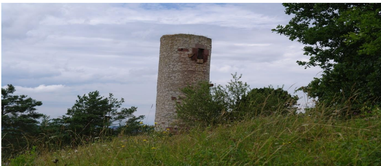
Das Ossendorfer Wahrzeichen der Heinturm wurde beim Einmarsch der Amerikaner von zahlreichen Granaten getroffen und beschädigt. Bereits kurz nach dem Kriege mauerten Ossendorfer die Stellen wieder aus.
